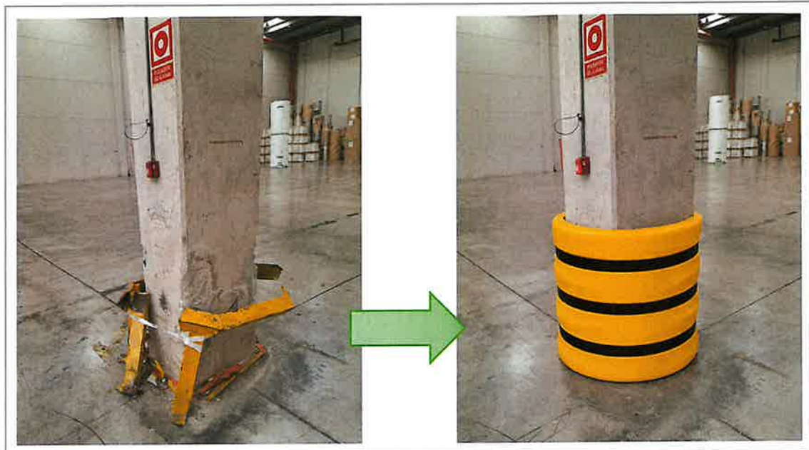
Figura 2 — Protección envolvente de pilar interior
