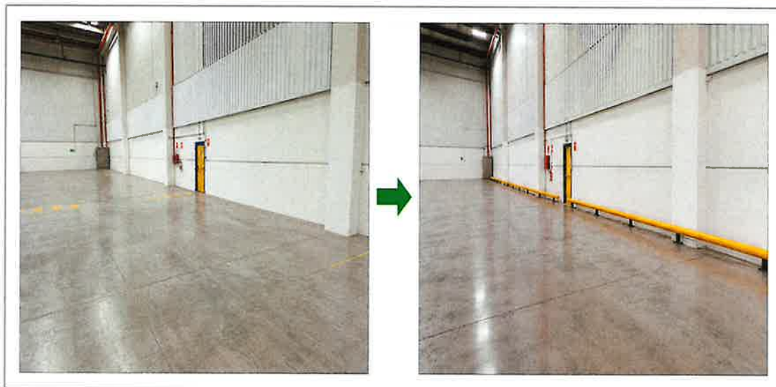
Figura 1 — Protección del paramento lateral
