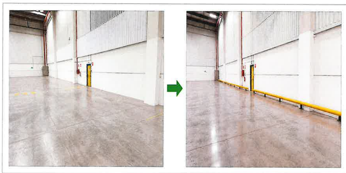
Figura 1 — Protección del paramento lateral
