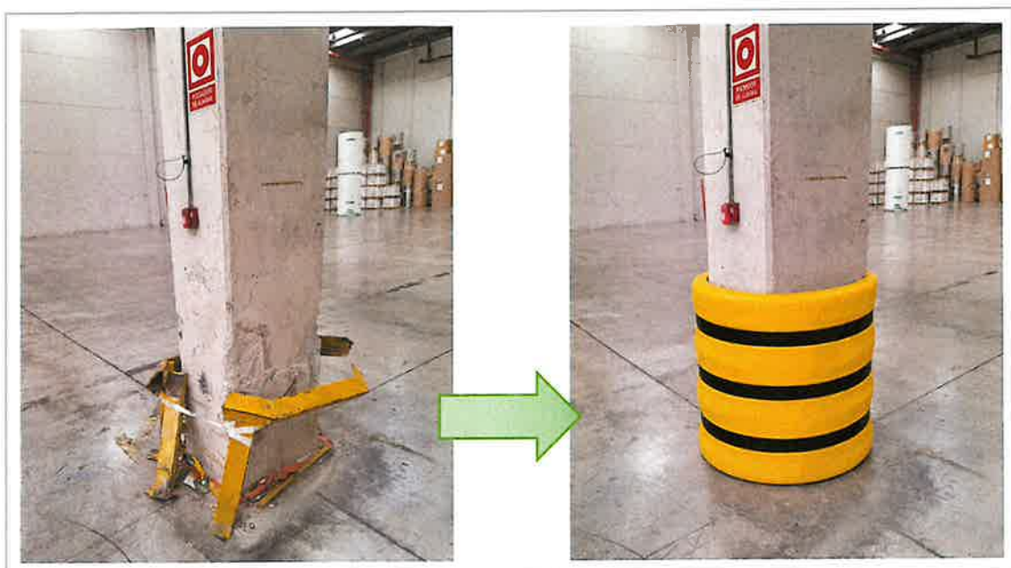
Figura 2 — Protección envolvente de pilar interior
