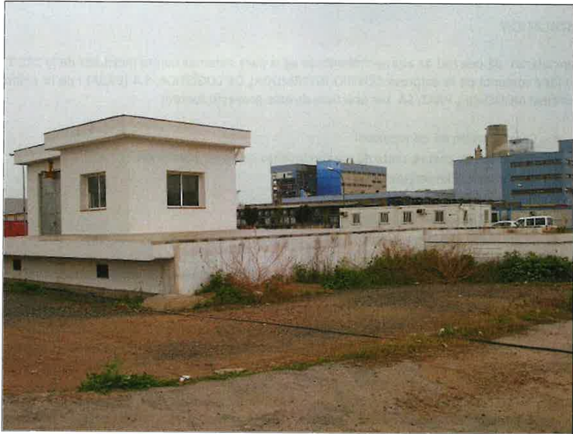
Fotografía nº 1: Estación contra incendios
