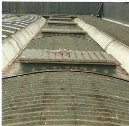
Detalle del aireador en cubierta Variant
