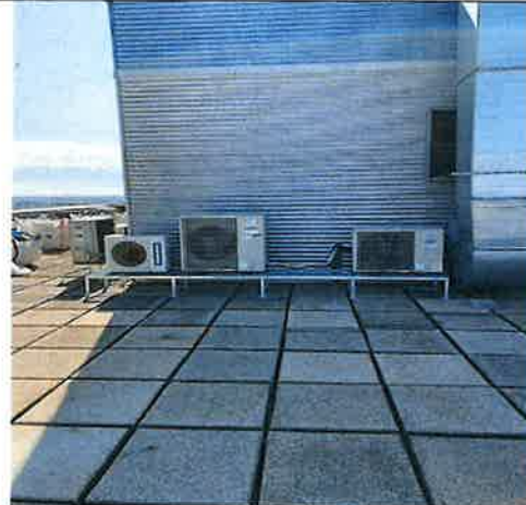
Detalle de losas filtrantes sobre soportes
