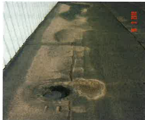
Detalle del sumidero sifónico autocebante
