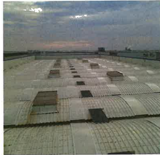
Detalle Exutores y lucernarios en cubierta Ypsilon
