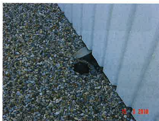
Detalle de sumidero en cubierta invertida
