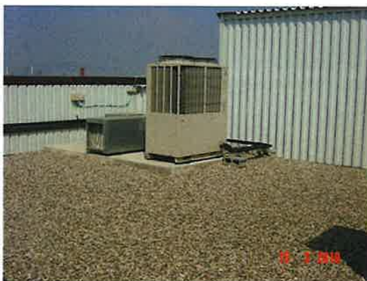
Cubierta invertida de oficinas
