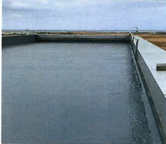
Detalle de impermeabilización en cubierta Service Center
