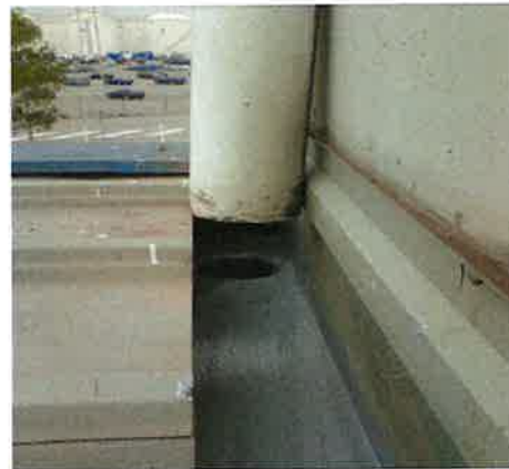
Vista superior del canal de recogida
