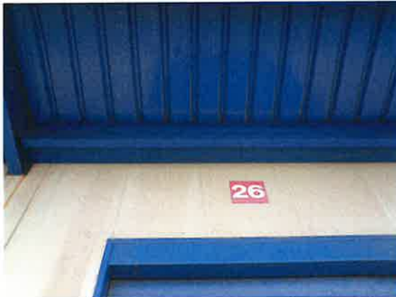
Canal de recogida de agua en marquesina de muelle de carga
