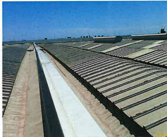
Vista general de cubierta
