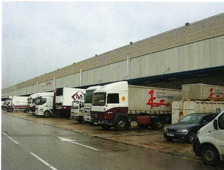
Vista exterior muelle de carga almacén
