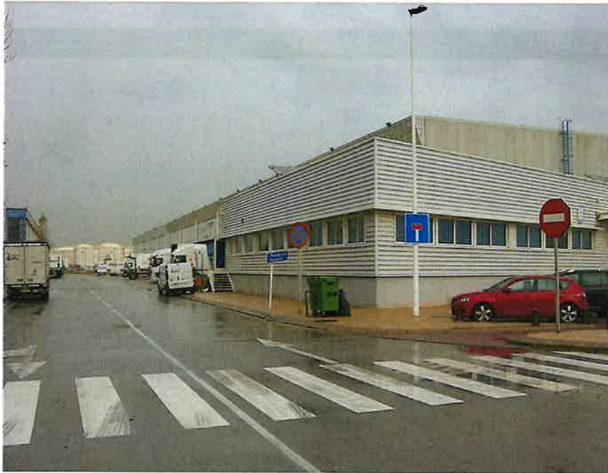
Vista exterior oficinas adosadas al Almacén
