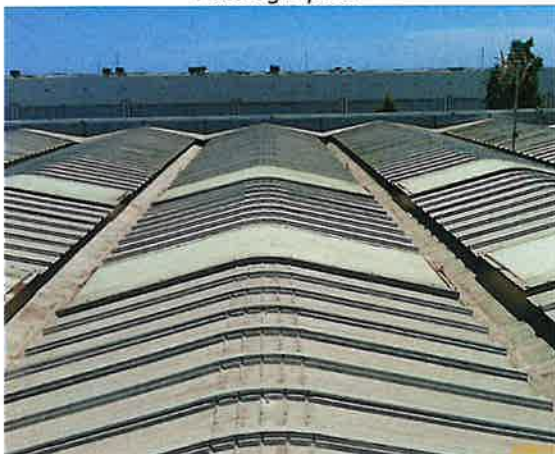
Vista general de cubierta
