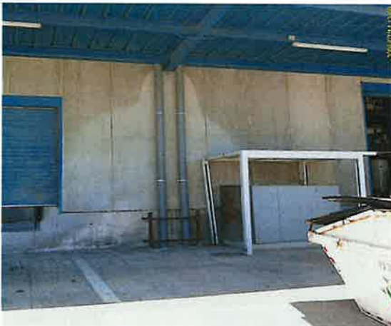
Marquesina Muelles de carga
