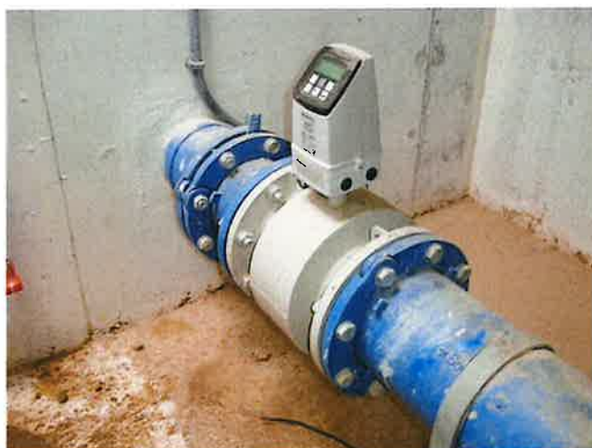
Fotografía nº 3: Caudalímetro electromagnético
