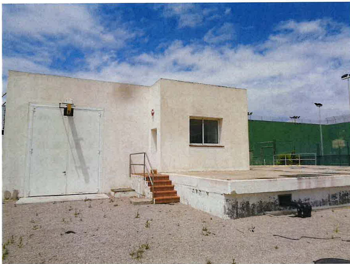
Fotografía nº 1: Estación contra incendios
