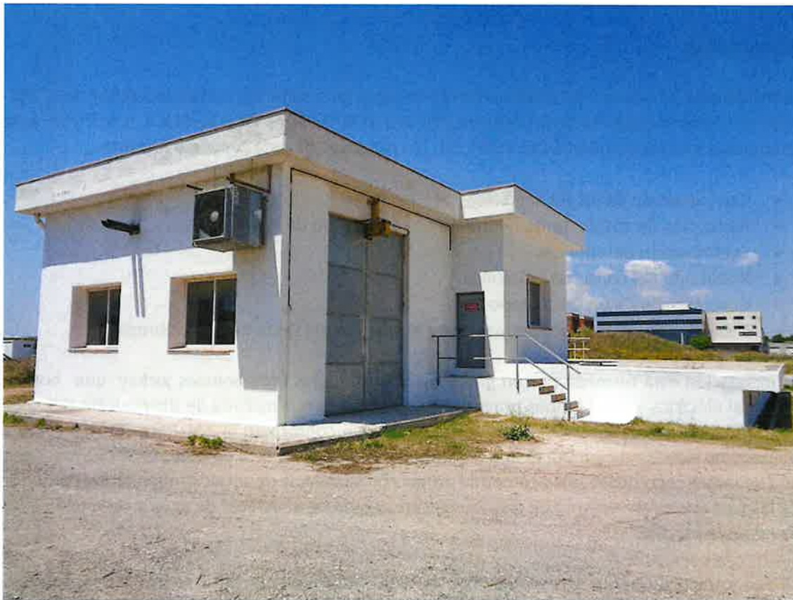
Fotografía nº 1: Estación contra incendios
