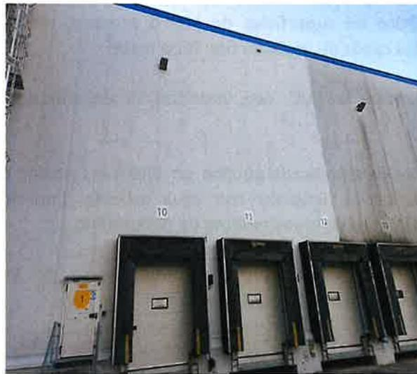
*Vista de la fachada tras la limpieza técnica (zona izquierda) y del estado previo afectado por residuos de combustible aéreo (zona derecha).*
