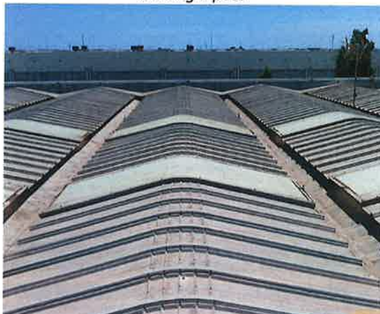
Vista general de cubierta
