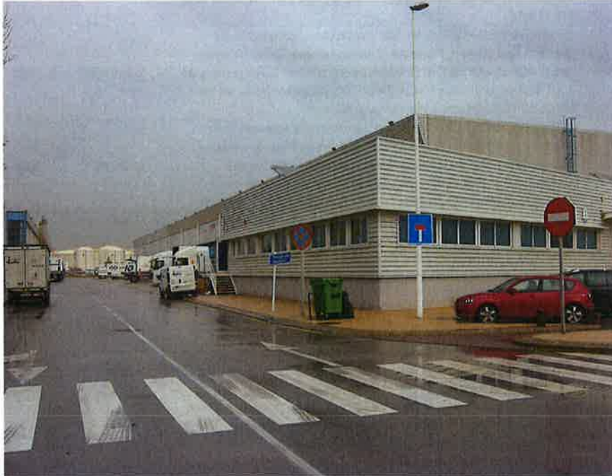
Vista exterior oficinas adosadas al Almacén
