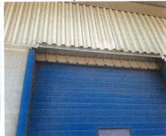
Detalle corte para suplementar altura
