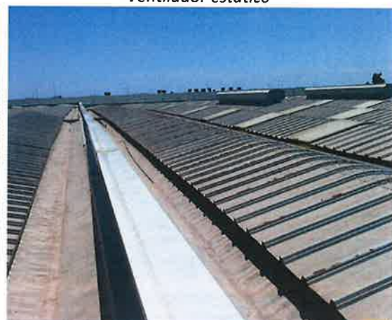
Vista general de cubierta
