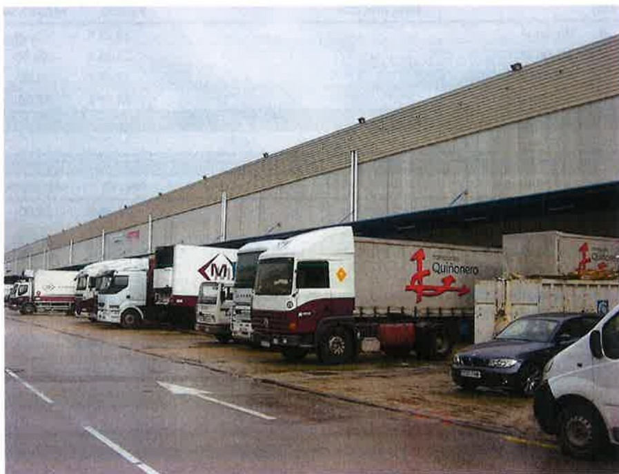
Vista exterior muelle de carga almacén
