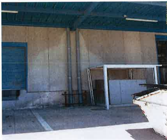
Marquesina Muelles de carga
