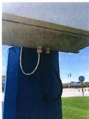
Este armario será estanco de 60x40x15. La ubicación del armario en el báculo se deberá realizar a una altura en que no resulte manipulable por personas a pie de calle, pero fácilmente accesible con escalera para tareas de mantenimiento y averías.
