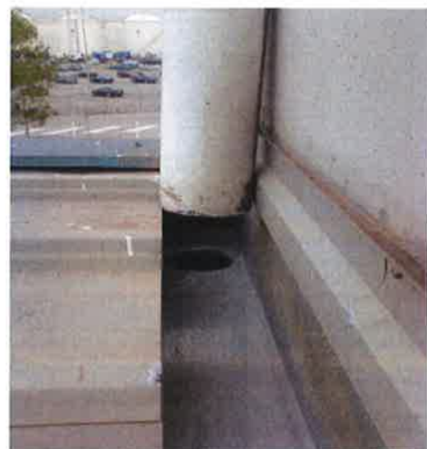
Vista superior Canal de recogida de agua en marquesina muelle de carga
