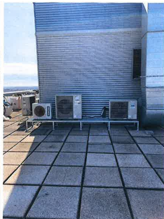
Detalle losas filtrantes cubierta Service Center
