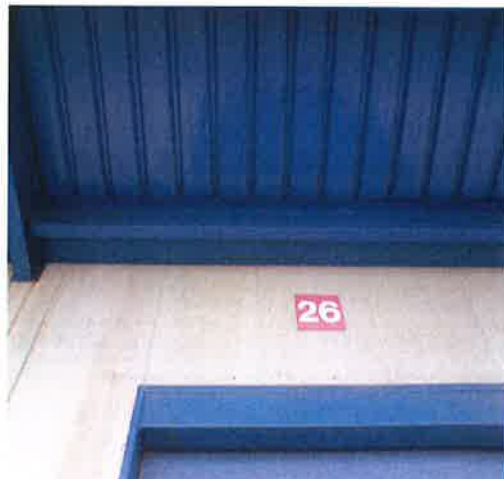
Canal de recogida de agua Marquesina muelle de carga
