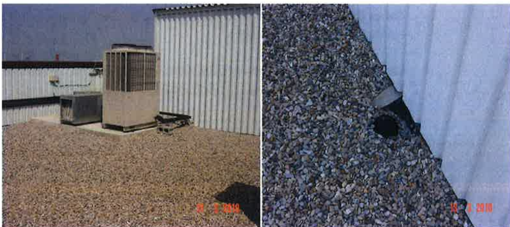
Detalle sumidero en cubierta invertida oficinas
