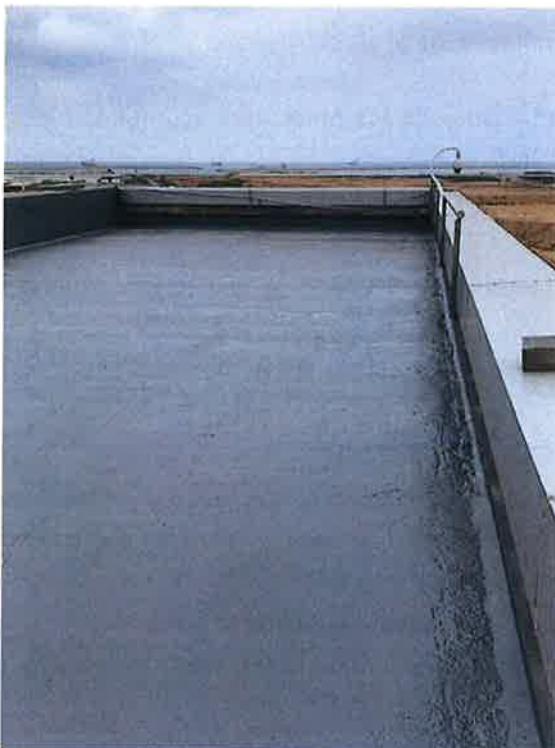
Detalle impermeabilización cubierta Service Center
