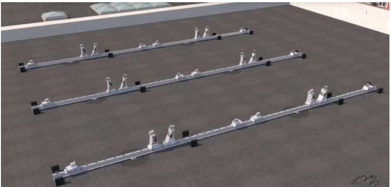
Detall de l'estructura amb orientació Est-Oest fixada a coberta
