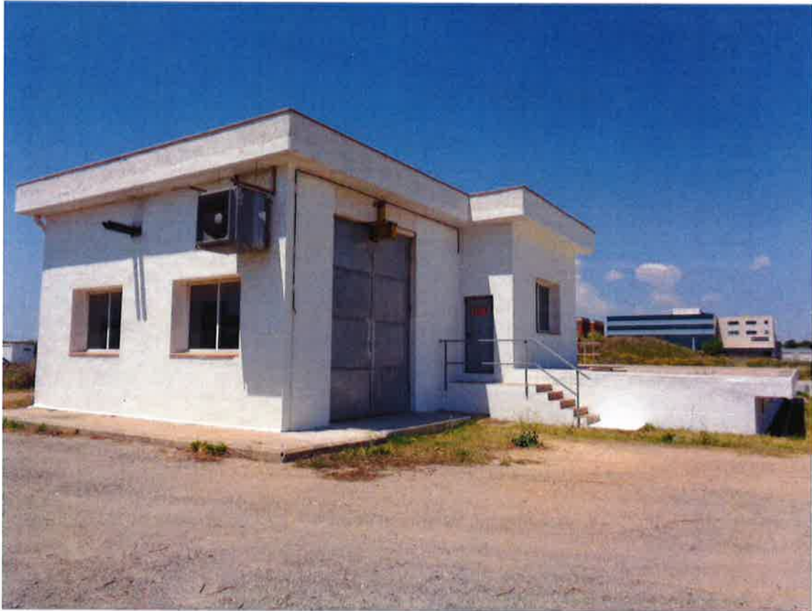
Fotografía nº 1: Estación contra incendios
