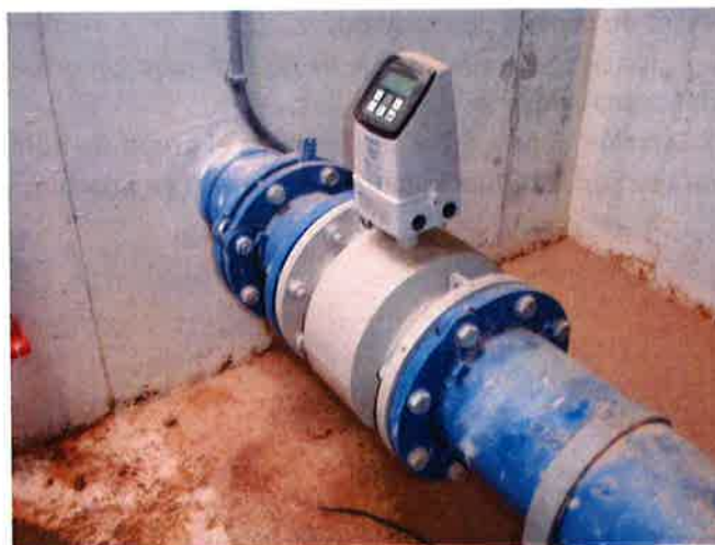
Fotografía nº 3: Caudalímetro electromagnético
