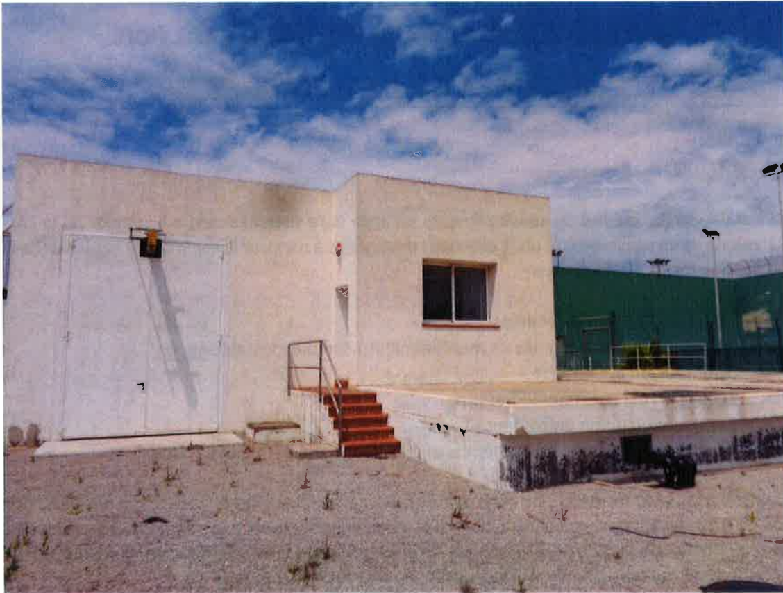
Fotografía nº 1: Estación contra incendios
