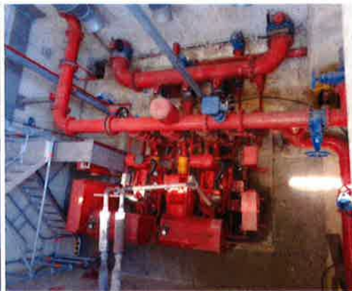
Fotografía nº 6: Sala de Bombeo
