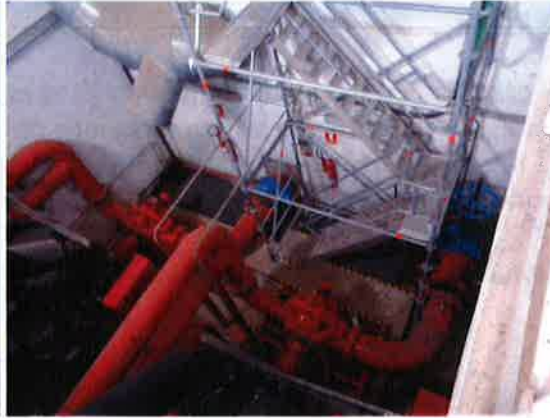
Fotografía nº 3: Sala de Bombeo
