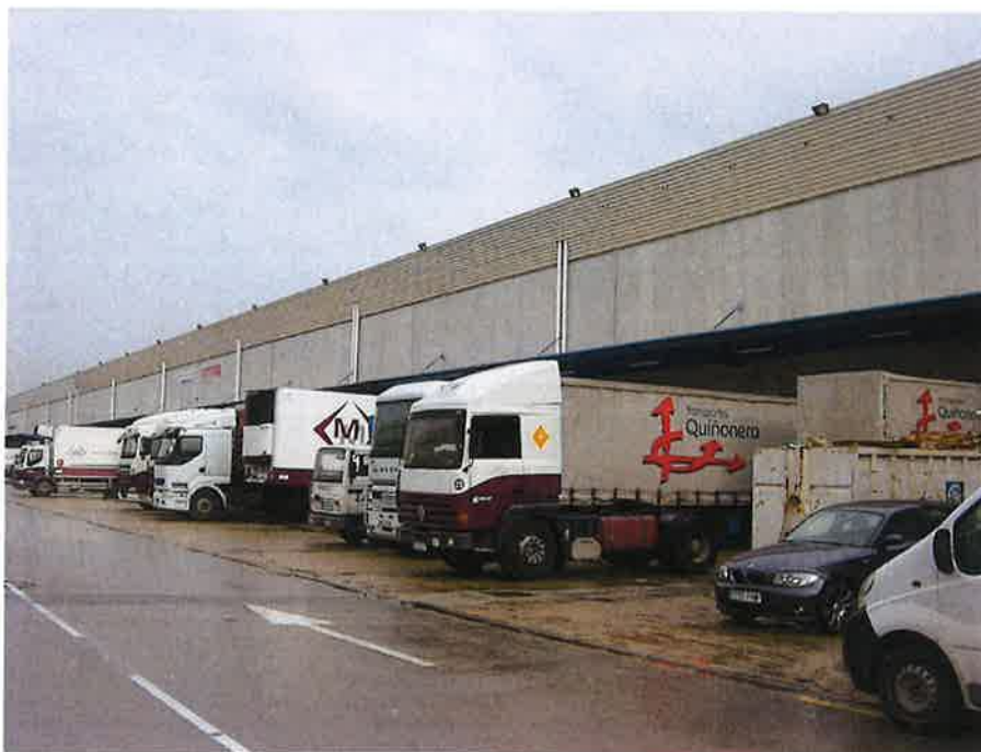
Vista exterior muelle de carga almacén
