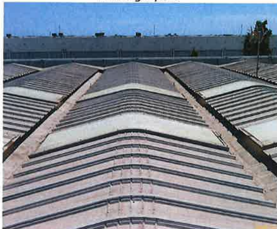
Vista general de cubierta
