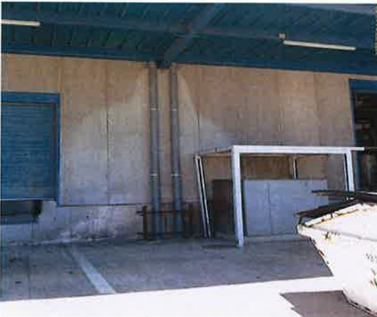
Marquesina Muelles de carga
