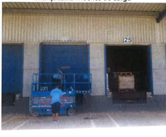
Patología Muelles de carga
