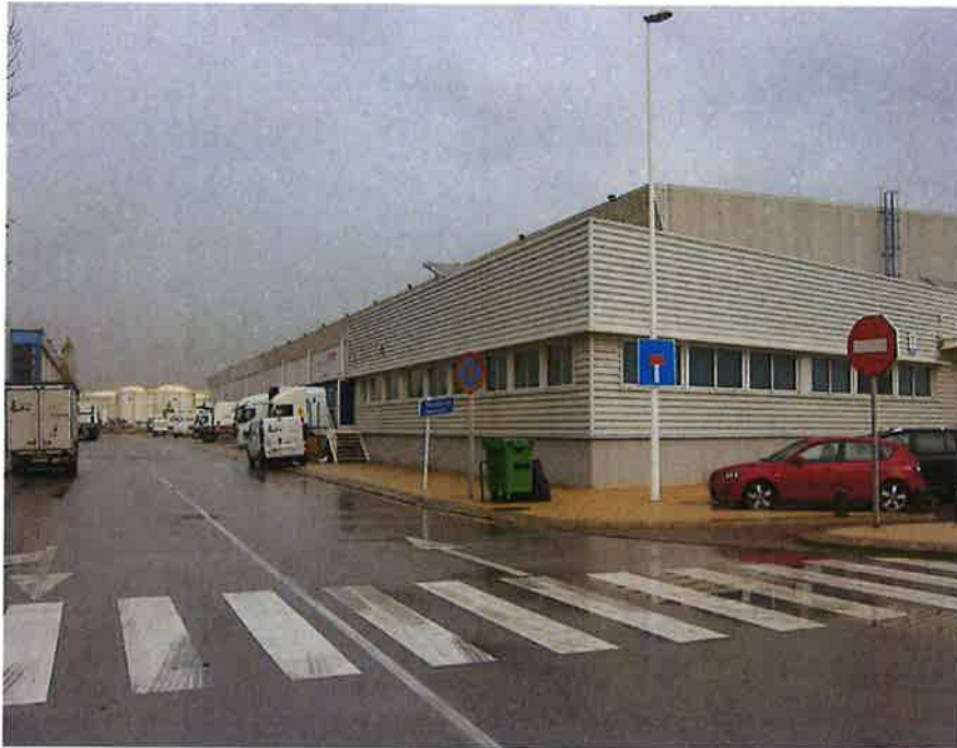
Vista exterior oficinas adosadas al Almacén
