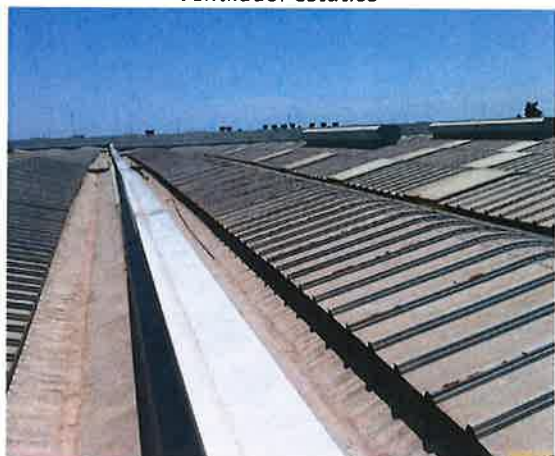
Vista general de cubierta
