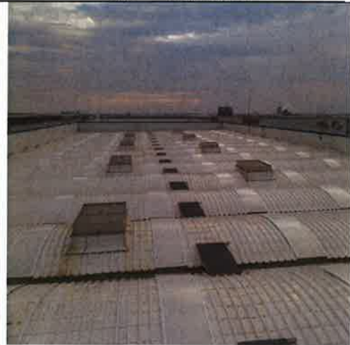
Detalle Exutores y lucernarios en cubierta Ypsilon
