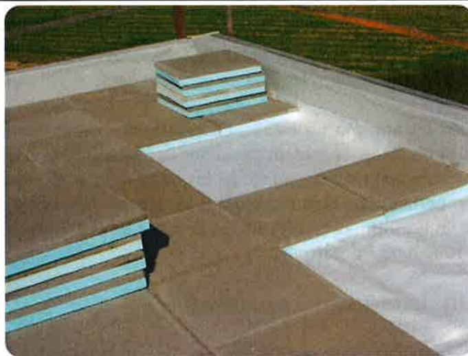
Detalle lamina impermeabilizante de PVC
