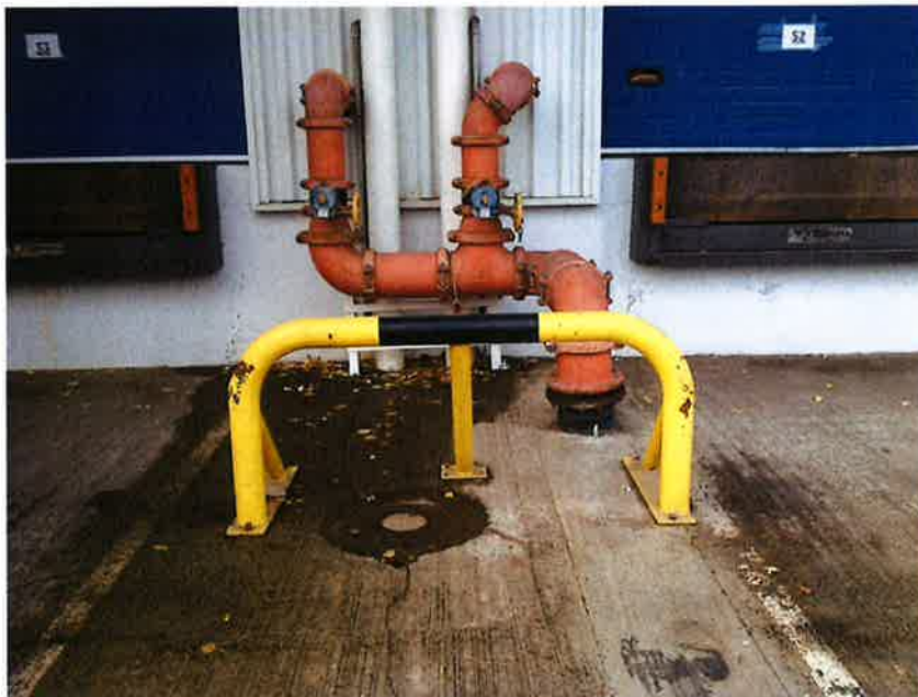
Protección tipo “gusano” Puesto de control
