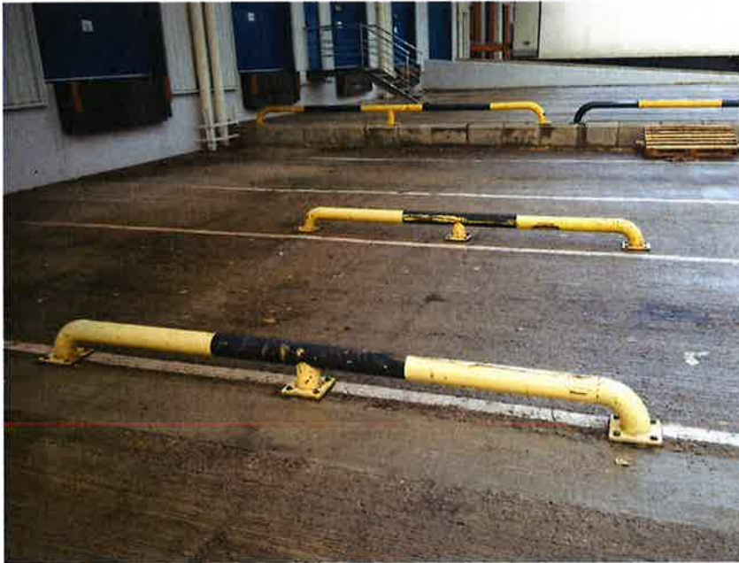
Protección tipo “gusano” muelle de carga
