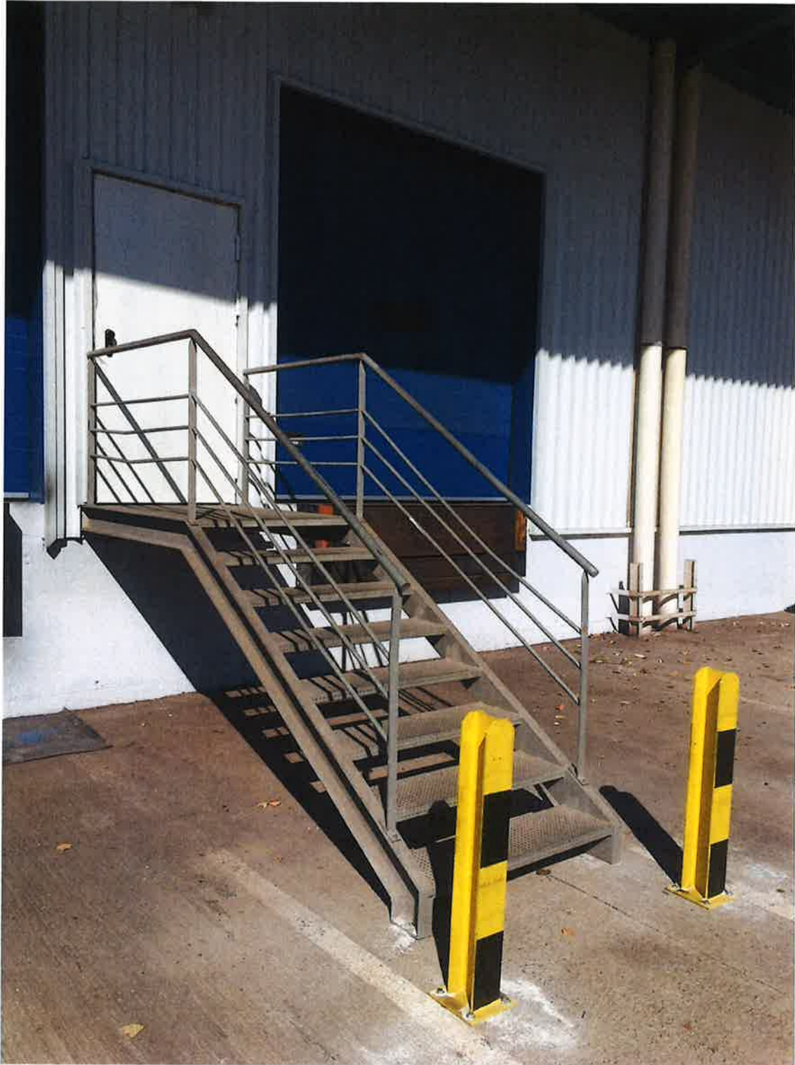
Estructura frontal de emergencia y protecciones metálicas HEB 120
